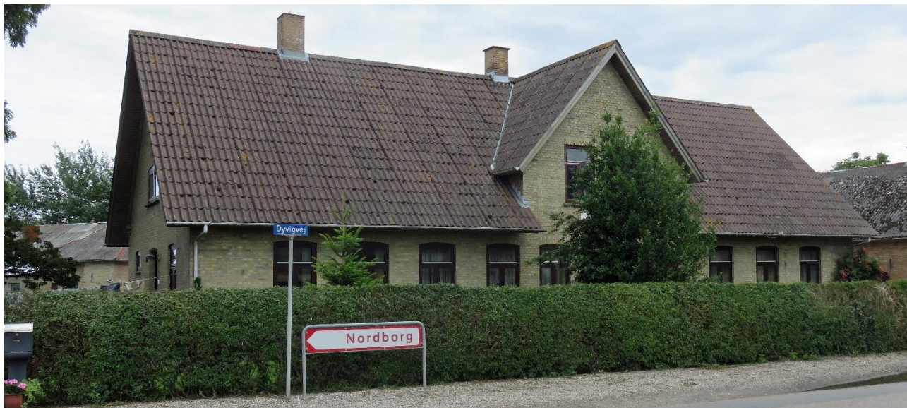
Dyvigvej 10, Holm, Nordborg (2020) – huset her er opført 1912!
